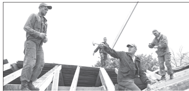
Чаще всего в детсадах требуют ремонта крыши, окна и электрика. Фото Д. Рыжакова
